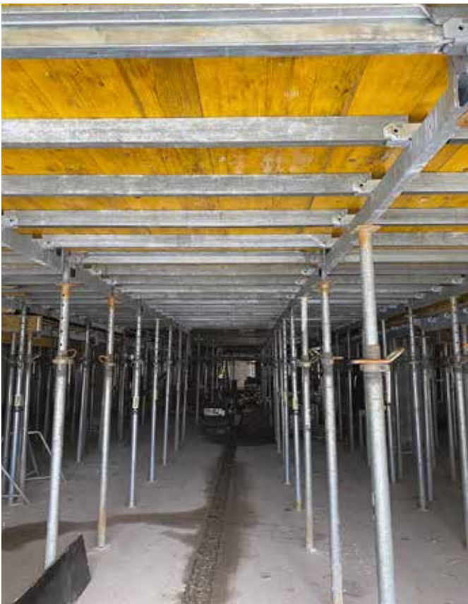
Mit dem modularen Deckensystem ONADEK werden die Decken der Tiefgarage effizient und wirtschaftlich geschalt.
