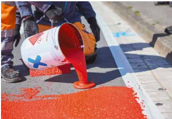
Triflex Line Kaltplastik wird direkt aus dem Eimer gegossen und anschließend mit einer Glättkelle über das eingemischte Griffigkeitsmittel abgezogen und verteilt. Bilder: Triflex
