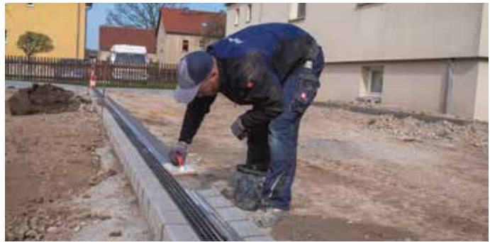
Die Stahlzargen der Betonrinne mit der innovativen Magnelis-Beschichtung ermöglichen einen effektiven Korrosionsschutz.
