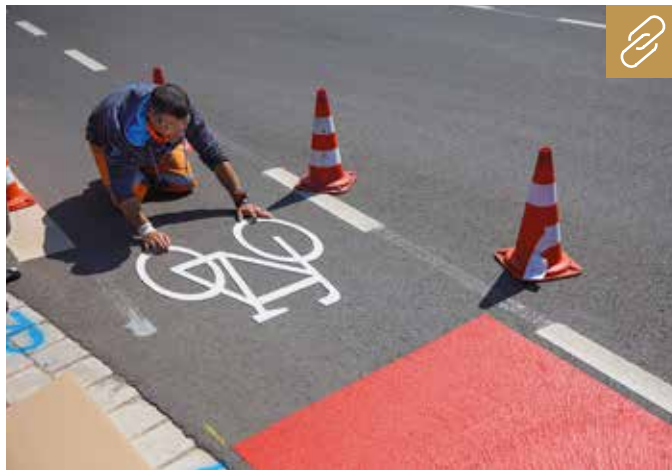
Als zweite Komponente des Markierungssystems kommt ein Radfahrer-Piktogramm aus der neuen Produktreihe EasyTherm zum Einsatz. Die Verarbeitung erfolgt einfach und ohne zusätzliche Technik.
