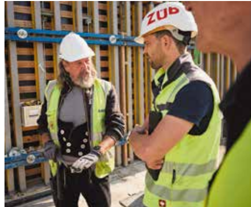
Partnerschaftliche Zusammenarbeit in Planung und Ausführung: Doka-Richtmeister Jörg Otte und Züblin-Bauleiter Sebastian Ortmeier.
