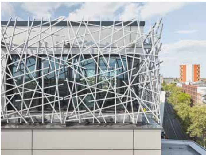
Einen Akzent setzt die neue sechste Etage mit einer Gitternetzstruktur als äußere Hülle. Diese erinnert optisch an ein Vogelneest.
