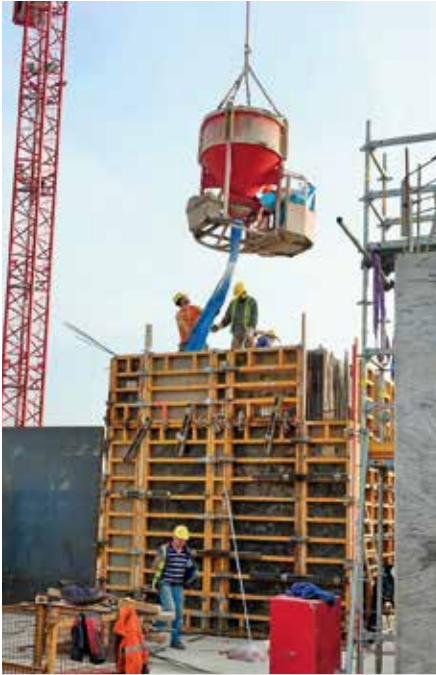
Für die Erstellung der Wände lieferte Ulma rund 3.500 m 2 ORMA Rahmenschalung.
