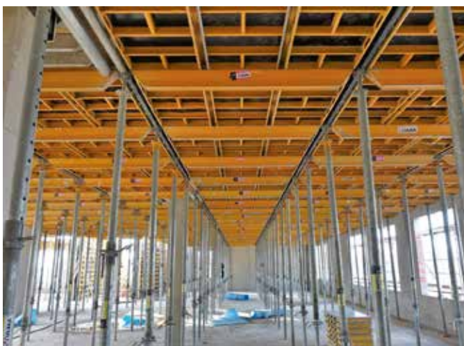
Flexibel, schnell, sicher: Die CC-4-Moduldeckenschalung punktet mit einer kürzeren Standzeit als herkömmliche Deckenschalungssysteme.
