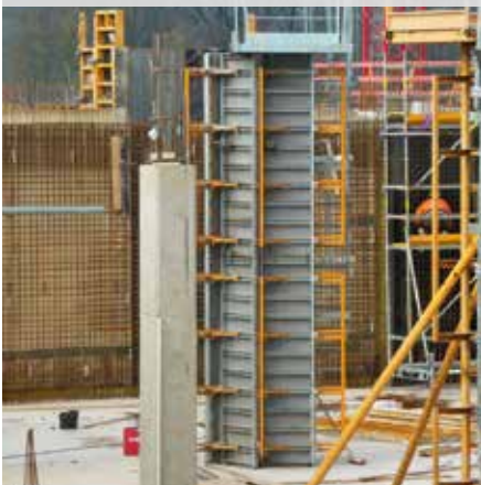
Die F-4 MAX Stützenschalung ist eine Lösung für besonders glatte Oberflächen.
