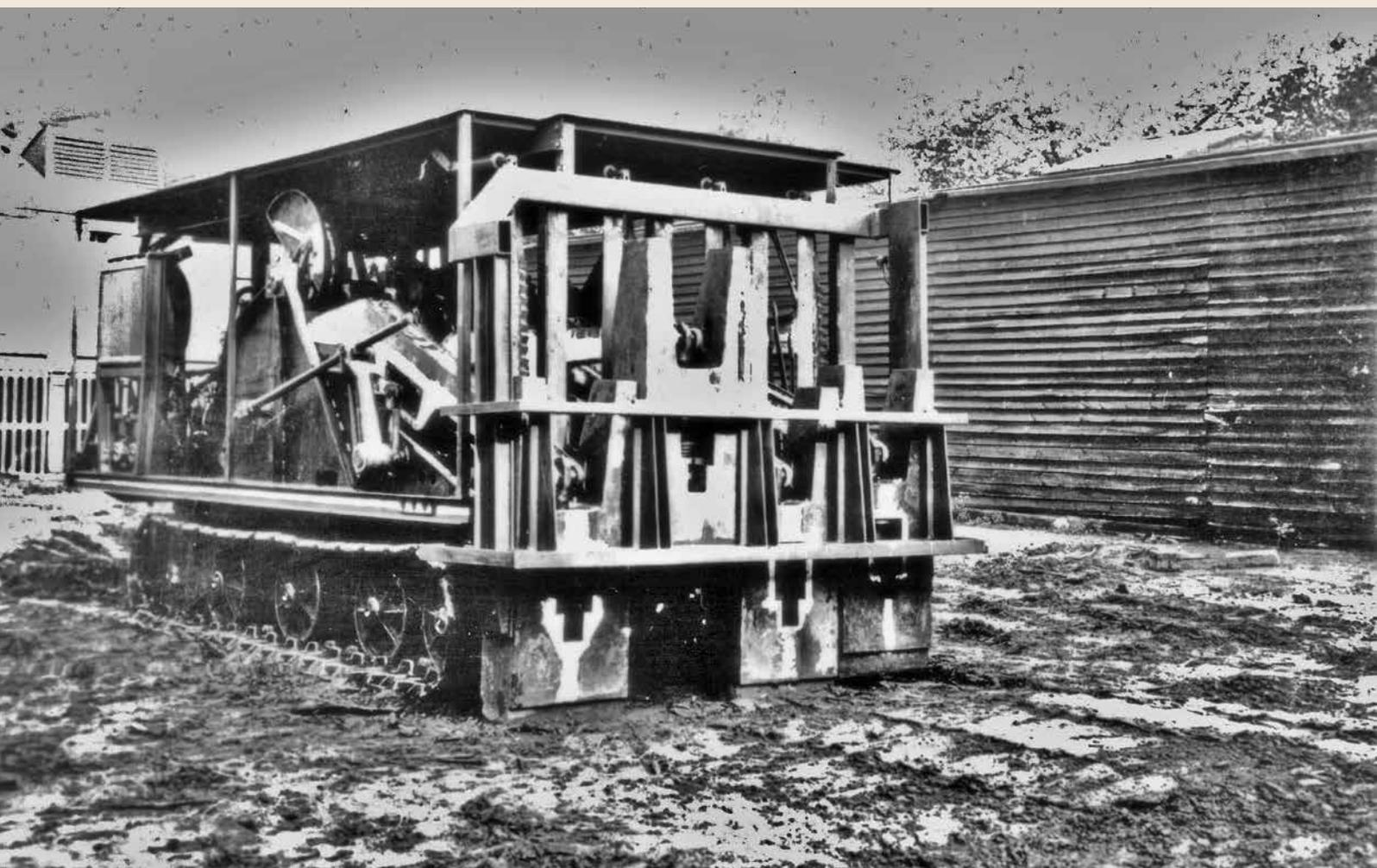
Auf die Hälfte oder gar ein Drittel senkte eine seltsame, auf Raupen fahrende Maschine mit mechanischen Stampfern die Verdichtungskosten, und das bei erheblich gesteigerter Effektivität. Bild: Archiv
