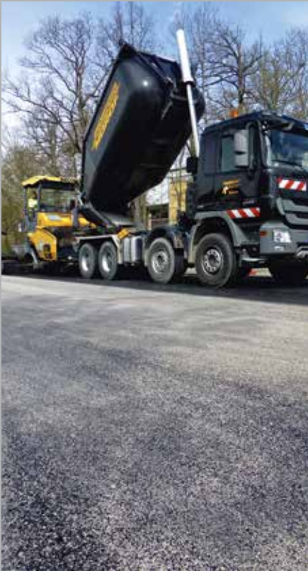
Während der Baumaßnahme wurde die Mischanlage und Baustelle in Echtzeit vernetzt.
