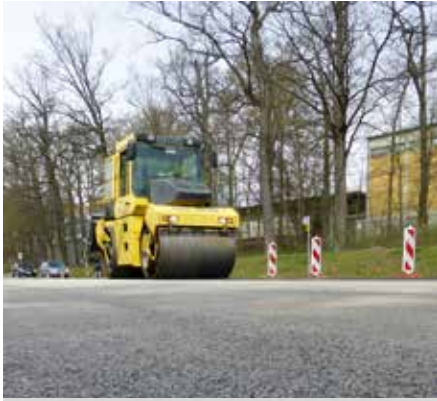
Auf der Baustelle in Vaihingen wurde ein Vögele-Straßenfertiger Super 1800-2, eine schemelgelenkte Tandemwalze Bomag BW 174 AD und eine knickgelenkte Kombiwalze Bomag BW 100 AC eingesetzt.
