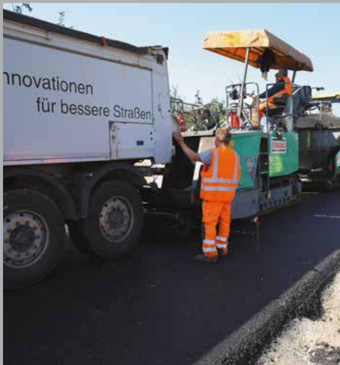
Die Temperatur des Mischguts wird permanent kontrolliert: Spezielle Thermocontainer sichern eine gleichbleibende Temperatur für einen nachhaltigen Einbau. Bilder: wyynot
