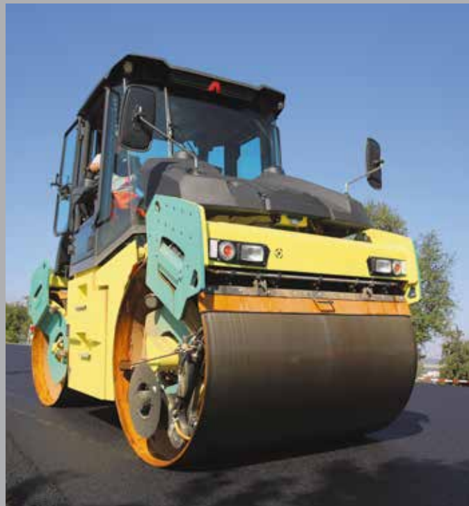
Die Walzen von Ammann sorgen für die fachgerechte Verdichtung des eingebrachten Materials. Durch die Verdichtungskontrolle (ACE) wird eine hohe Qualität der Arbeit gewährleistet.
