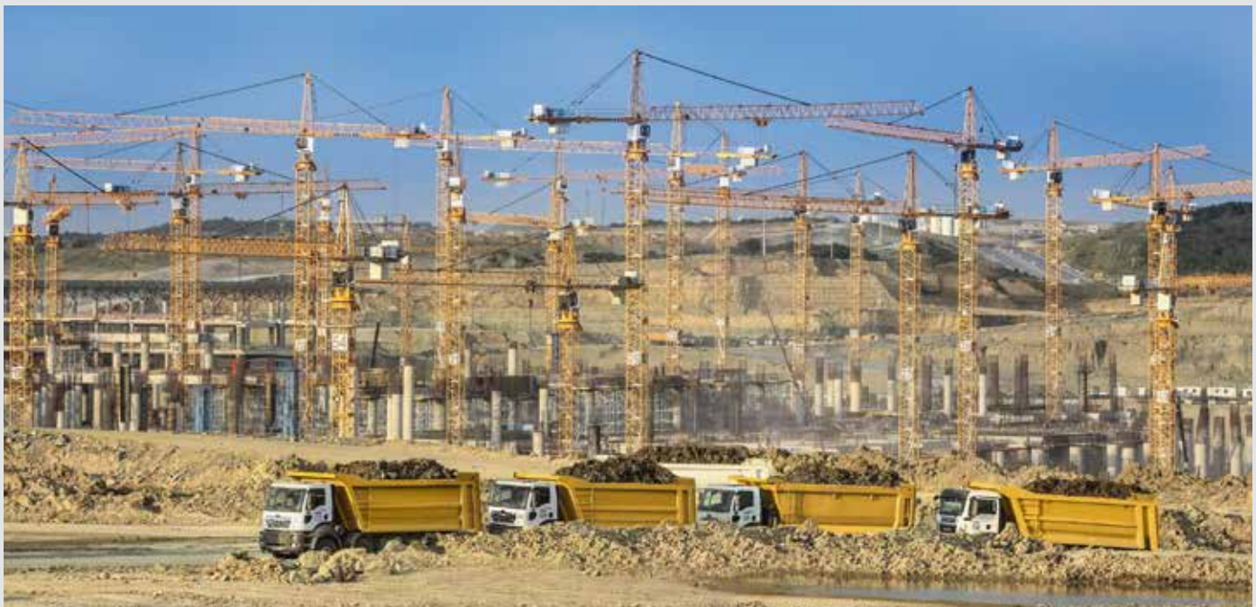
Die Litronic-Krane verfügen über präzise Hochleistungsantriebe und eine intelligente Kransteuerung. Beides gewährleistet eine hohe Sicherheit für Menschen und Material bei Hakenhöhen zwischen 30 und 60 m und maximalen Tragfähigkeiten von jeweils bis zu 12 t. Bild: Liebherr
