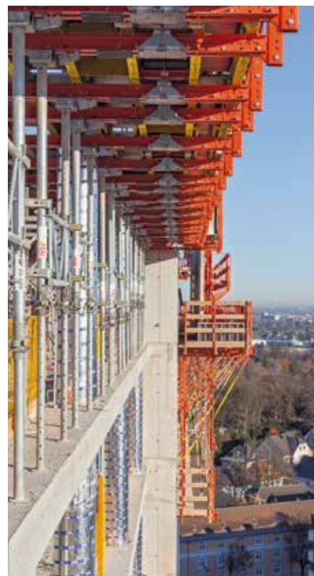
Zur Herstellung des Gebäudekerns bildeten CB Kletterbühnen und die TRIO Rahmenschalung kranbare Kletterschalungseinheiten.
