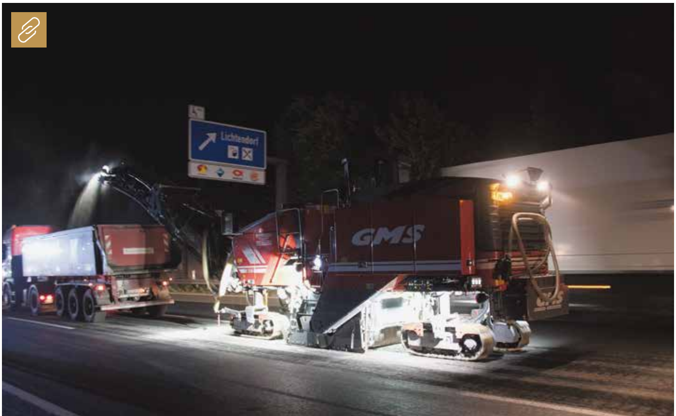
Wirtgen Großfräse W 210i. Dank präziser Fräsprozesse und Multiplex-Nivelliersystem sorgten die Fräsen für eine hohe Ebenheit der Fahrbahn – und ideale Voraussetzungen für den Dünnschichteinbau. Bild: Wirtgen Group
