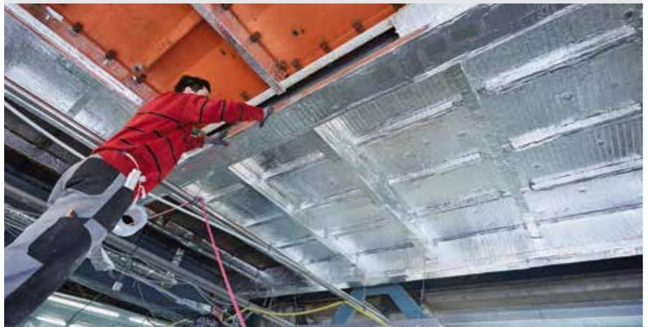
sche Gründe: In weiten Teilen wird später eine Lochblech-Rasterdecke als Unterdecke abgehängt. Die Installationen im Deckenhohlraum – teils ebenfalls mit aluminiumkaschierten Dämmstoffen isoliert – fallen so kaum ins Auge, die gesamte Installationsebene wirkt dezent.
