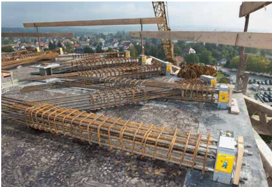
Das tragende Wärmedämmelement Isokorb Typ KS garantiert einen wärmebrückenarmen Anschluss von frei auskragenden Stahlträgern an Stahlbetondecken. Bild: Schöck
