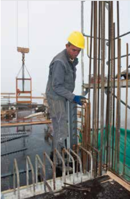
Der ehemals 34 m hohe Turm wurde auf eine Schaftlänge von 20 m abgetragen, um fünf weit auskragende Geschosse in Stahlbeton-Bauweise aufzustocken. Bilder: Schöck
