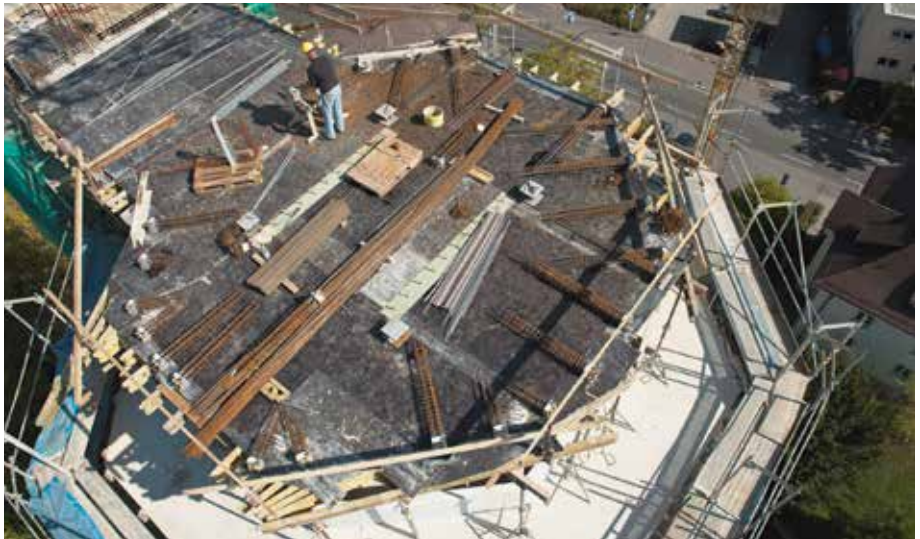
Der ehemals 34 m hohe Turm wurde auf eine Schaftlänge von 20 m abgetragen, um fünf weit auskragende Geschosse in Stahlbeton-Bauweise aufzustocken. Bilder: Schöck
