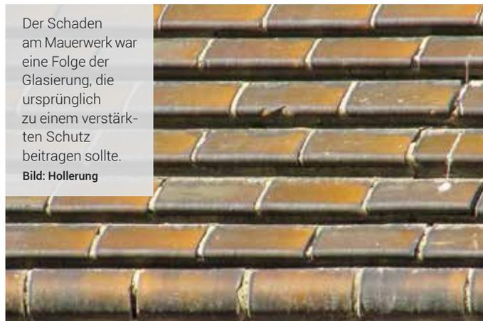
Der Schaden am Mauerwerk war eine Folge der Glasierung, die ursprünglich zu einem verstärkten Schutz beitragen sollte.
