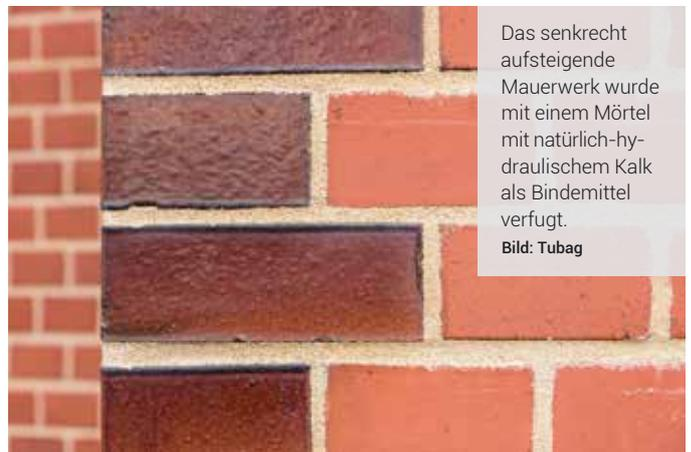
Das senkrecht aufsteigende Mauerwerk wurde mit einem Mörtel mit natürlich-hydraulischem Kalk als Bindemittel verfugt.
