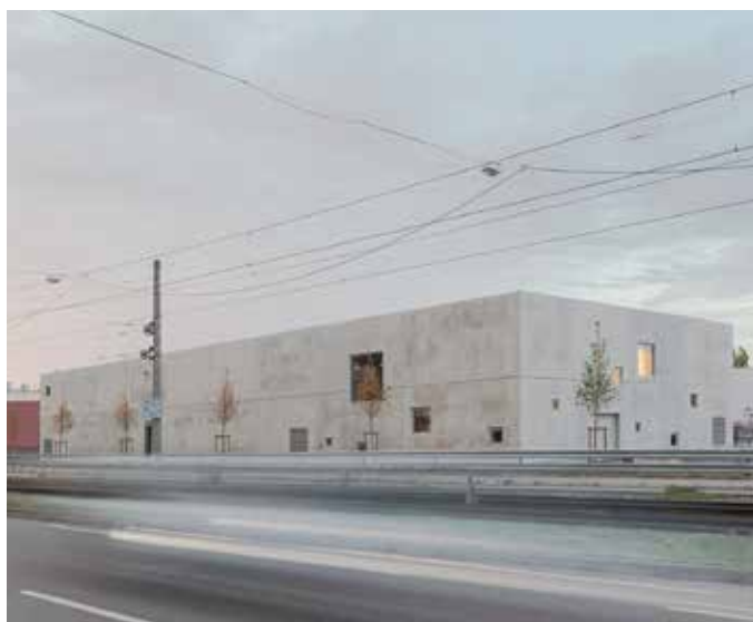
Aus wirtschaftlichen Gründen entschieden sich die Architekten für eine Lösung aus Beton-Fertigteilen und Ortbeton. Bilder: Brigida Gonzalez
