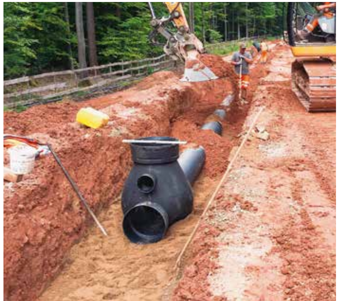
Die AquaTrafficControl-Schächte machen die Rohrleitungen kontrollier- und spülbar. Als Huckepacklösung haben sie Anschlüsse für die AquaPipe-Transportrohre und die Sickerleitungen Strabusil.
