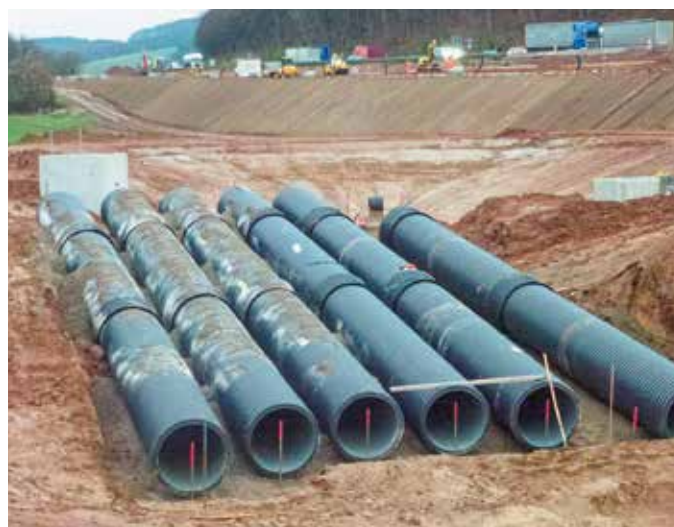
Das AquaPipe-System zum Ableiten des Oberflächenwassers. Dieses erfüllt hohe Anforderungen an Langzeitbeanspruchung und statische Belastungen mit Verkehrslast SLW 60/HGV 60.
