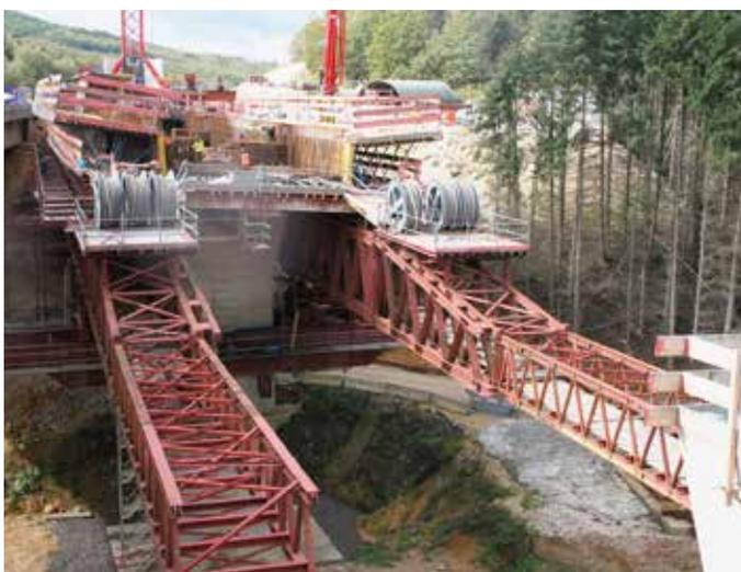
Das Vorschubgerüst muss der wechselnden Querneigungen von -6 % bis zu +6 % der späteren Fahrbahn folgen. Daher musste die Konstruktion höhenverstellbar ausgeführt sein. **Bilder: Thyssenkrupp Infrastructure**
