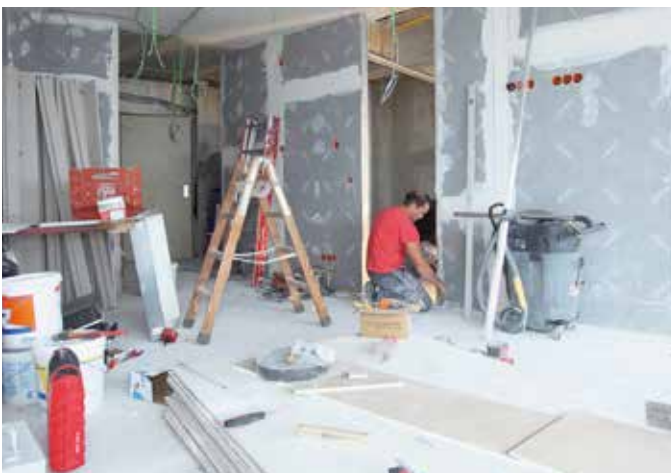
Die innenliegenden Gipsdielenwände, abgehängte Decken, Bodenbeläge sowie sämtliche Elektro- und HLS-Installationen wurden demontiert.
