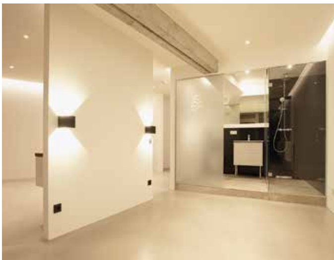
Im Badezimmer montierten die Profis eine abgehängte Decke mit einer in C3-hoch ausgeführten Unterkonstruktion. Die Beplankung erfolgte mit einer Lage der Platte Rigips Glasroc X Bilder: bild-text-ton.de/Thermo Isolierbau
