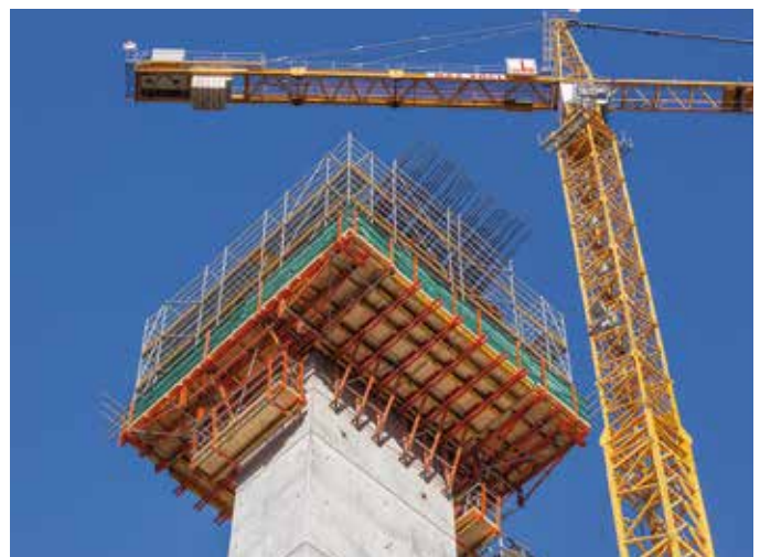
In den Aufweitungsbereichen am Pfeilerkopf sorgten Arbeitsbühnen auf Basis der RCS und SCS Klettersysteme für die Lastabtragung. Ein PERI UP Bewehrungsgerüst bot eine sichere Arbeitsumgebung.
