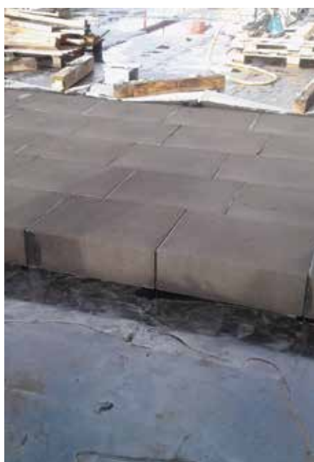
Sowohl die Dämmung des Daches als auch der Besucherterrassen wurde mithilfe von Schaumglasplatten von Foamglas ausgeführt.
