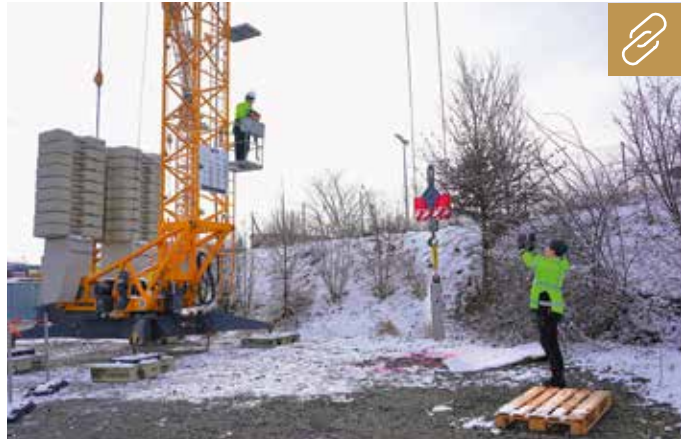
Beutlhauser ist autorisierter Liebherr-Partner für die zertifizierte Ausbildung als Turmdrehkranführer. Bild: Beutlhauser
