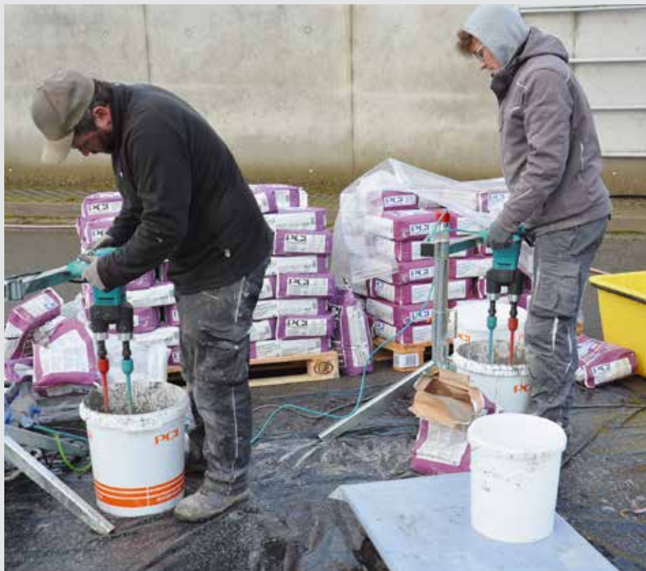
Jobst-Bau entschied sich für den Einsatz von zwei Collomix Xo 55 duo Rührwerken in Verbindung mit jeweils einem Rührständer RMX, um die technischen Vorgaben des Materials einhalten und zeitgleich die körperliche Belastung für die Mitarbeiter reduzieren zu können. Bilder: Collomix
