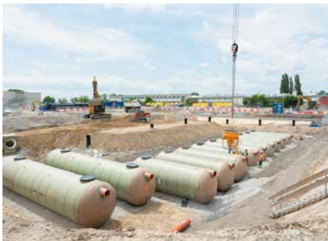
Der Technische Filter ACO Stormclean bildet die Grundlage für eine fachgerechte und zukunftsorientierte Regenwasserbehandlung.
