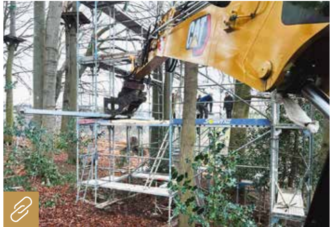
RotoTop macht den Bagger zum Schweizer Taschenmesser. So kann der Stahlträger aufgenommen und in mehreren Metern Höhe an der richtigen Stelle platziert werden. Bild: Holp
