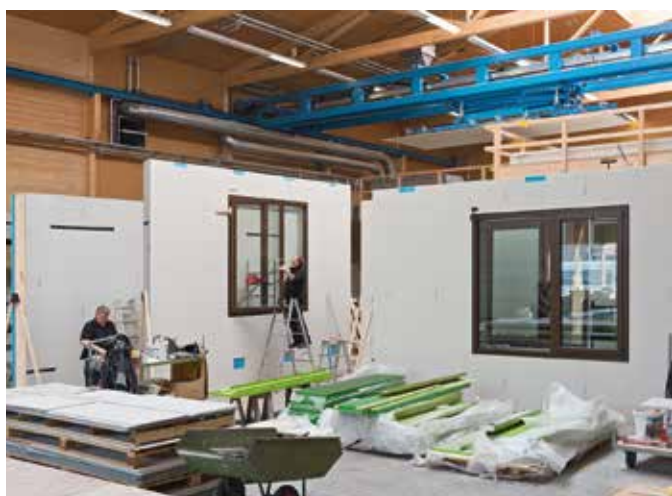
Sämtliche Fassadenelemente wurden in den Werkhallen der Zimmerei Sieveke GmbH mit hohem Vorfertigungsgrad produziert.
