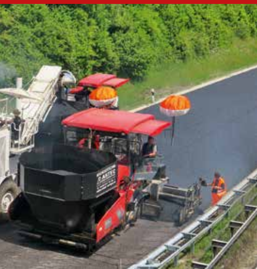
Weil Sattelzüge ihre 25 t Mischgut in nur 60 Sekunden in den Kübel des Beschickers abkippen, fördert der Vögele Power Feeder MT-3000-2i bis zu 1200 t/h Mischgut zum Fertiger, was unterbrechungsfreien Einbau ermöglicht. Bild: Vögele
