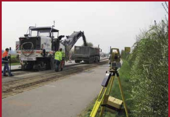
Für hochpräzise und sehr ebene Fräsresultate werden auch bei Kaltfräsen immer häufiger Maschinensteuerungen genutzt, hier eine Topcon-Steuerung von Wansor aus Gevelsberg. Bild: Wansor
