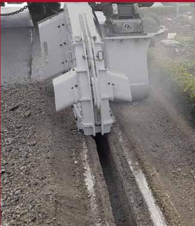
Die mit Fräsmeißeln bestückten SMW Schneidräder von Kinshofer sind speziell für Schlitz in Asphalt sowie weiche und mittelharte Gesteine geeignet. Mit ihnen können schnell und präzise schmale Gräben aus dem Untergrund herausgefräst werden. Bild: Kinshofer
