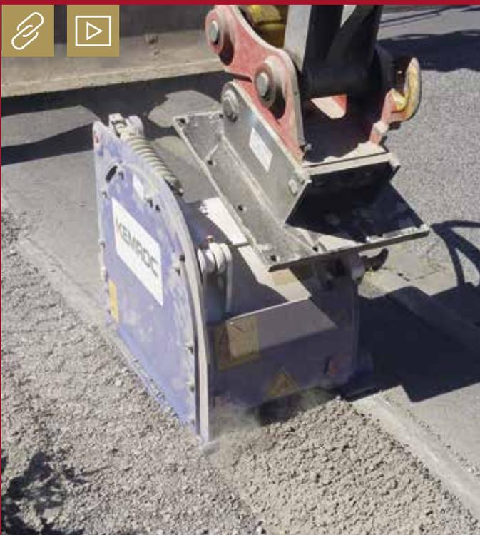
Die Exactor-Anbaufräsen von Kemroc zeichnen sich durch die Möglichkeit des millimetergenauen Fräsens bis 19 cm Tiefe dank der justierbaren Tiefeneinstellung aus. Bild: Kemroc
