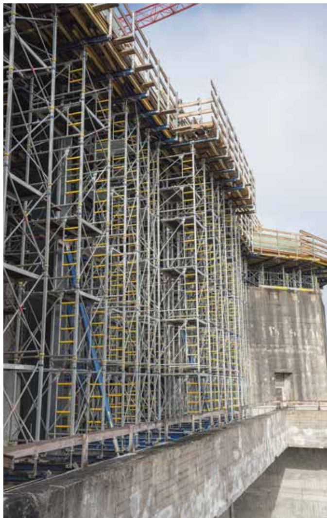
Auf dem Bunkerkragen kam das Traggerüst Staxo 100 zum Einsatz, das als Unterstellung der auskragenden Decke dient.
