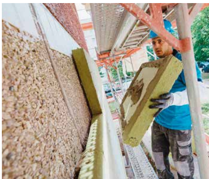
Die Coverrock II ist eine nichtbrennbare Putzträgerplatte für WDV5 in der Wärmeleitfähigkeit 035. Durch eine hoch verdichtete Oberlage werden gute Putzhaftung und einfache Verdübelung ermöglicht.
