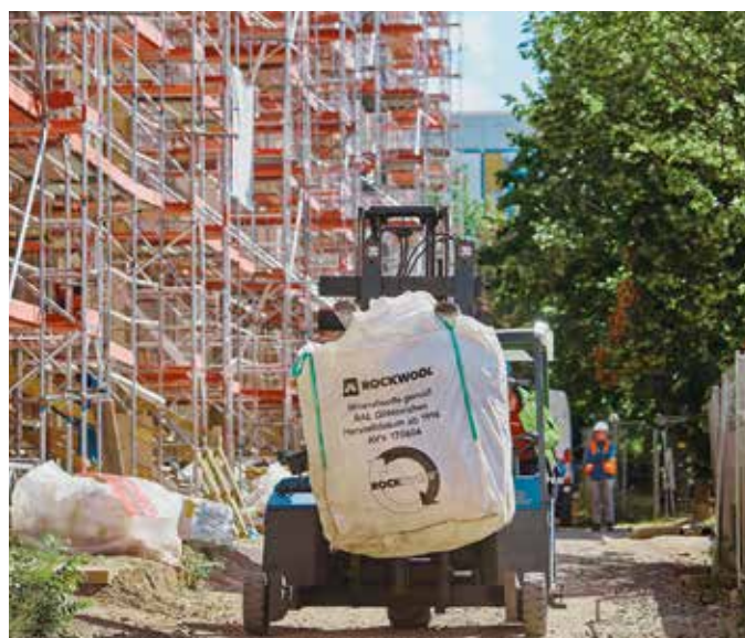
Reststücke der Steinwolle-Dämmplatten, die zu klein sind und auf der Baustelle nicht mehr verarbeitet werden konnten, sammelten die Mitarbeiter der BRW in BigBags von Rockwool. Bilder: Rockwool
