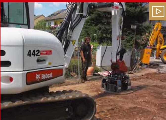
Die SBV-Plattenverdichter sparen 50 % Energie gegenüber herkömmlichen Verdichtungsgeräten ein, was zu entsprechend weniger Kraftstoffverbrauch und CO 2 -Emissionen führt. Bild: Stehr
