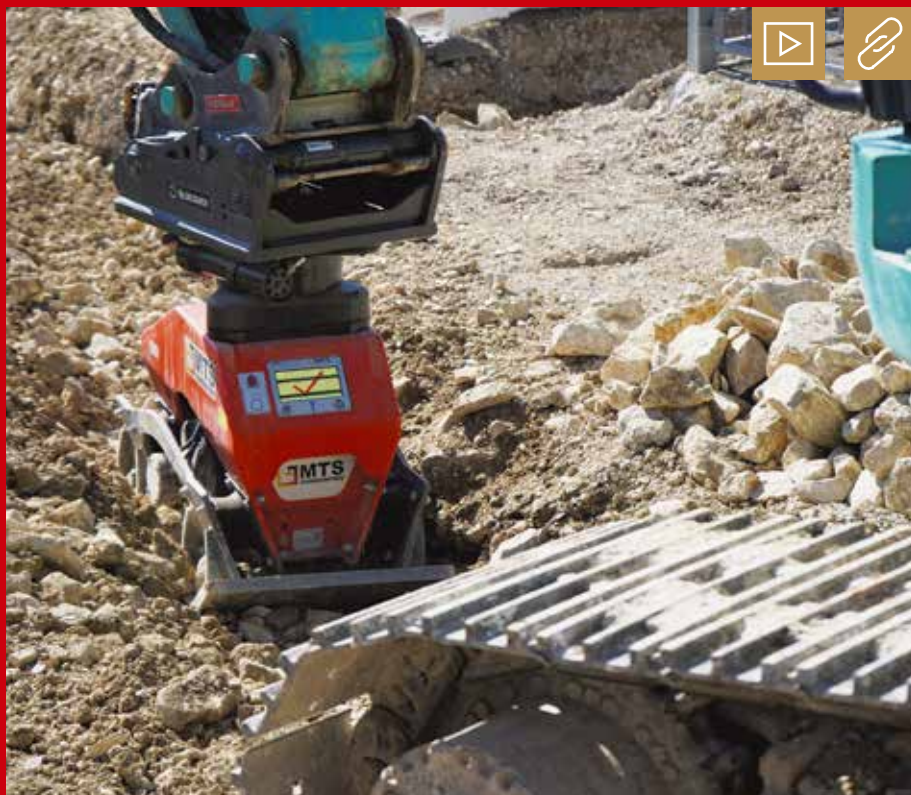
Der neue Eva-Anbauverdichter von MTS gibt Auskunft, ob die gewählte Frequenz im gewünschten Bereich liegt, ob und wie die Auflast zu korrigieren ist und wann das Ende der Verdichtung erreicht ist. Bild: MTS
