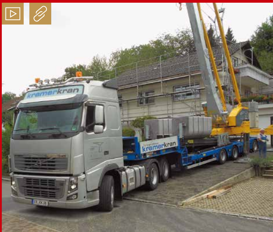
Die KK-Verlegesysteme von Kramer Kran funktionieren auf Basis des „Underride-Verfahrens“. Kran und Ballastierung kommen dabei nicht mehr getrennt auf die Baustelle, sondern auf einem Tieflader. Bild: Kramer Kran
