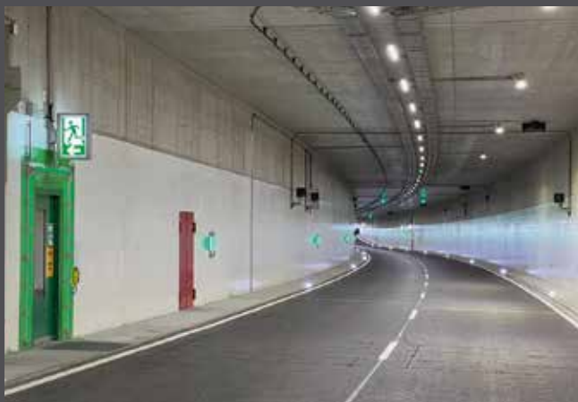
Der Tunnel wurde nach fünfeinhalb Jahren Bauzeit im Oktober 2022 in Betrieb genommen. Die Beschichtung der Tunnelwände erfolgte mit Produkten des Herstellers Sika. Bild: Kasig
