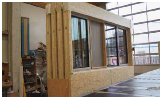
Die Außenwände wurden in Holzrahmenbauweise gefertigt und bereits werkseitig mit den Fensterelementen versehen. Bild: Brüninghoff
