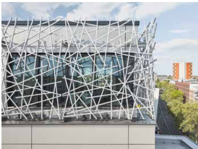
Einen Akzent setzt die neue sechste Etage mit einer Gitternetzstruktur als äußere Hülle. Diese erinnert optisch an ein Vogelnest.
