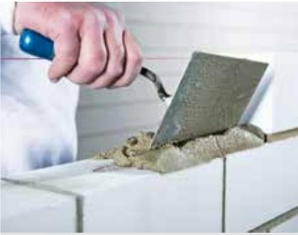
Für KS-Sichtmauerwerk ist der Werk-Trockenmörtel dem Baustellenmörtel vorzuziehen.
