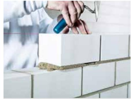
Nach dem Setzen wird der KS-Verblender an der gespannten Schnur ausgerichtet.
