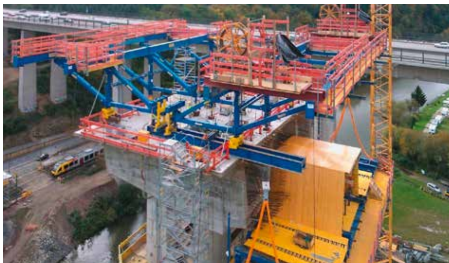
Doka konstruierte aus Bögl-Eigenmaterial eine spezielle Litzenheberbühne für den Freivorbau. Damit waren die Bodenroste ohne große Autokrane direkt vom Boden hochzuziehen. Bilder: Doka
