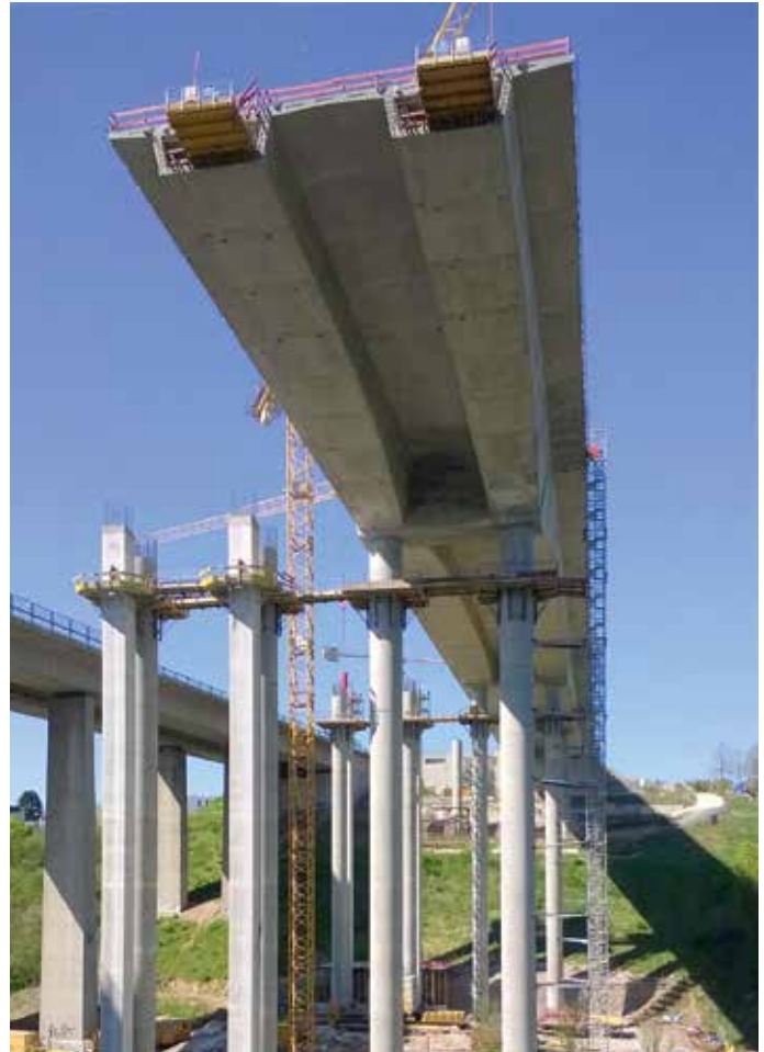
Die Überbauten der 450 m langen Balkenbrücke aus gevouteten zweizelligen Spannbetonhohlkästen entstehen im Freivorbau.
