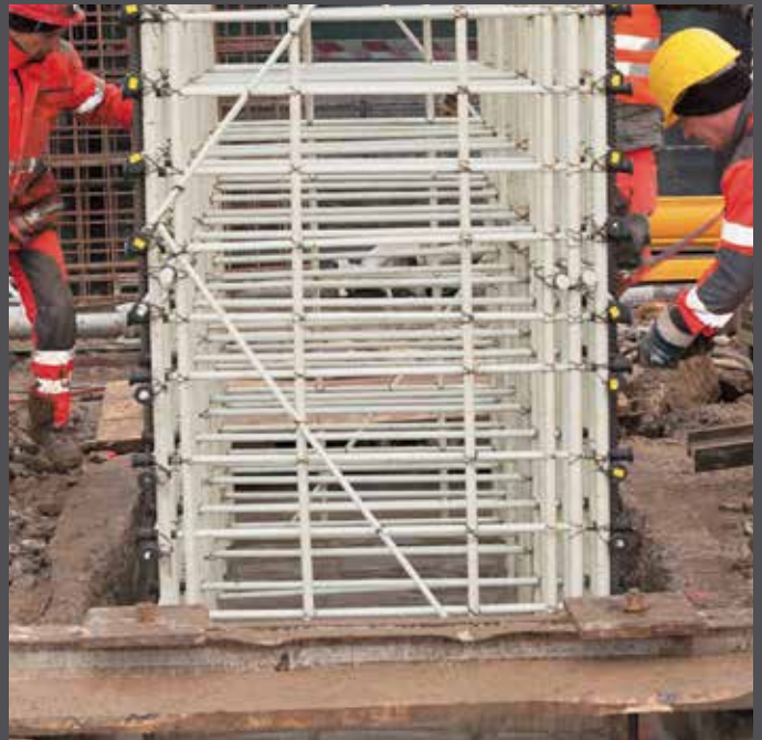
Ablassen des Soft Eye-Bewehrungskorbs in den Schlitz. Insgesamt verarbeitete der Stahlbauer rund 100 t Combar bei diesem Projekt. Bilder: Schöck
