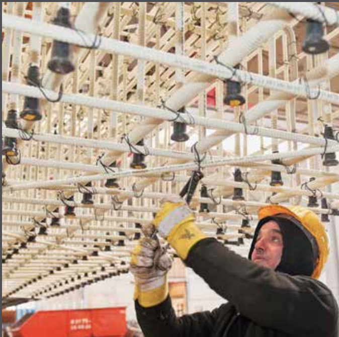
Fertigung eines Bewehrungskorbes mit Combar. An rund 1.000 Kreuzungspunkten werden die Combar-Stäbe zu Bewehrungskörben gebunden.
