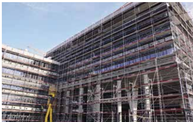
Betontechnisches Highlight und Eyecatcher innerhalb des Foyers sind drei ineinander verschränkte, 11 m hohe Stützen. Sie tragen die Last der 1.200 t schweren und 700 m 2 großen Foyerdecke.
