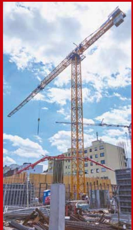
Die Krane der Serie TL sind geeignet für Baustellen mit mehreren Kranen, die übereinander schwenken müssen. Bild: Eurogru
