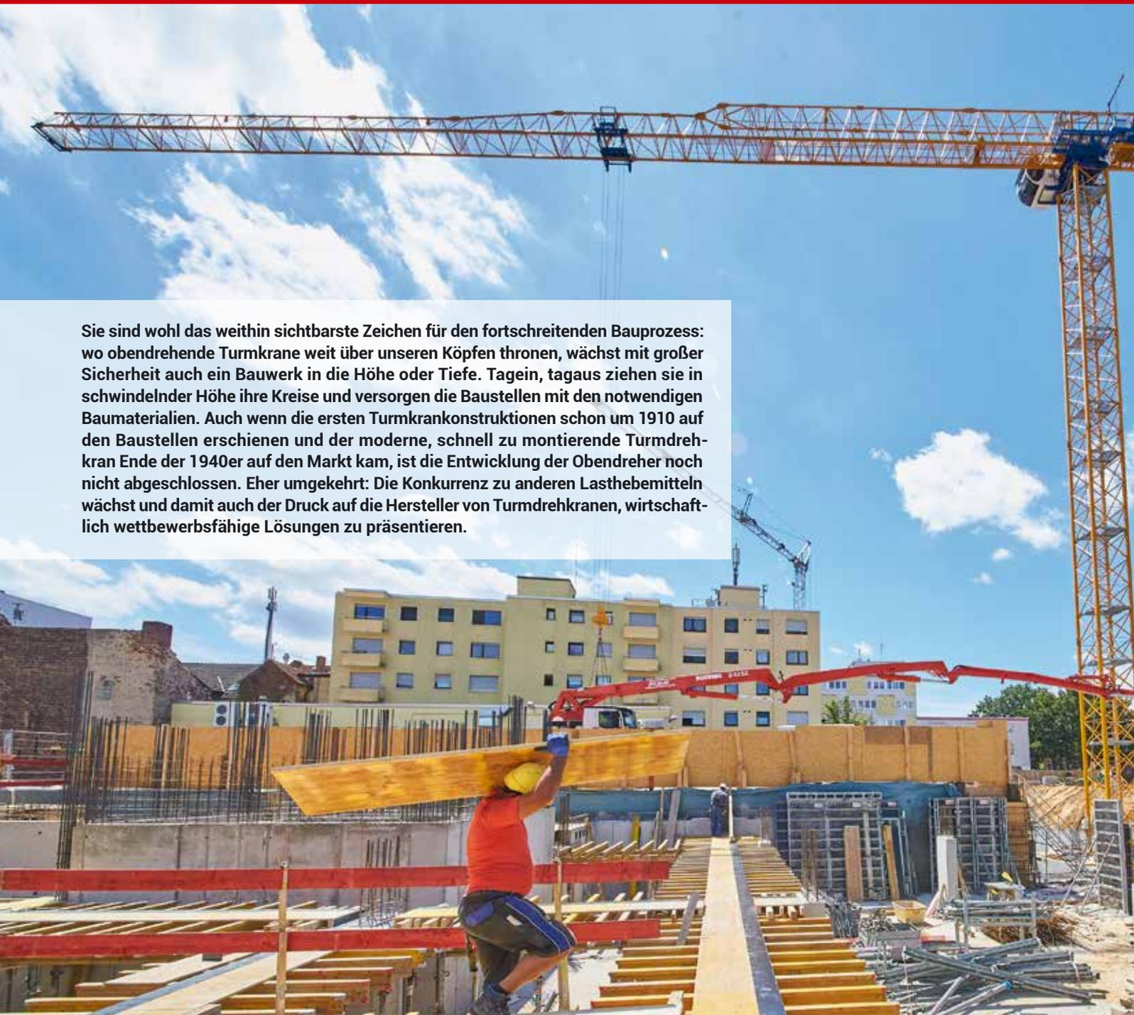
Durch sein einfaches Bolzensystem und die monolithischen Elemente ist der Topless Obendreher TL 63.21 von Eurogru in wenigen Stunden montiert und einsatzbereit. Bild: Eurogru
