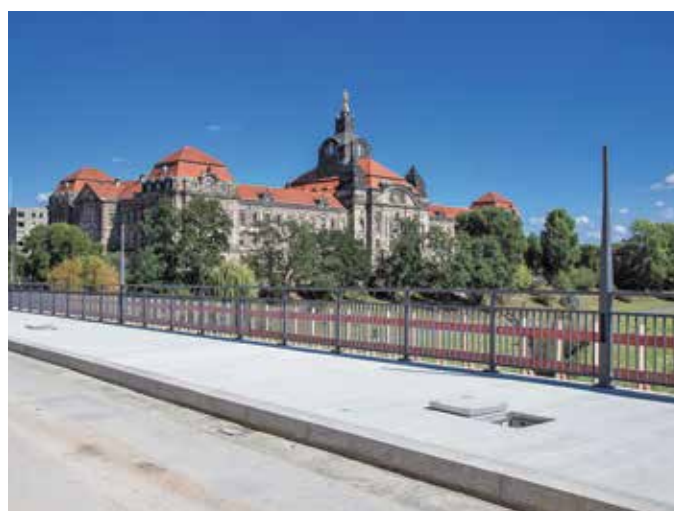
Der Geh- und Radweg wurde von 3,60 auf 4,25 m verbreitert. Mit herkömmlichen Materialien wäre das statisch nicht möglich. Bilder: Stefan Gröschel, TU Dresden
