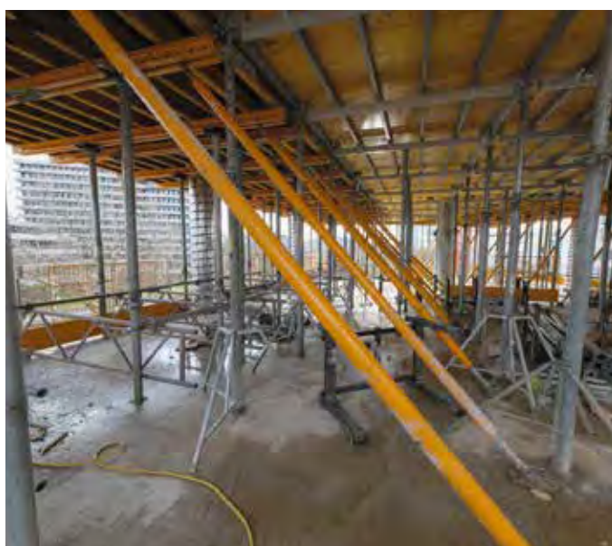
Für die Erstellung der aufwendigen Deckenkonstruktionen kamen unter anderem 750 m 2 des neuen Deckensystems ONADEK sowie 600 m 2 MK-Deckentische zum Einsatz. Bilder: Ulma
