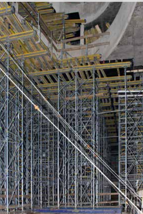
Systemteile aus dem SL-1-Baukasten dienen zur Überbrückung der großen und geschwungenen Öffnungen im Inneren des Gebäudes. Bild: Doka
