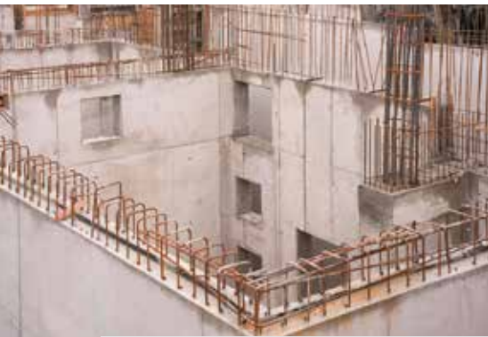
Der Rohbau stellte die Verantwortlichen vor knifflige Aufgaben, die sie mithilfe sNoe meisterten.
