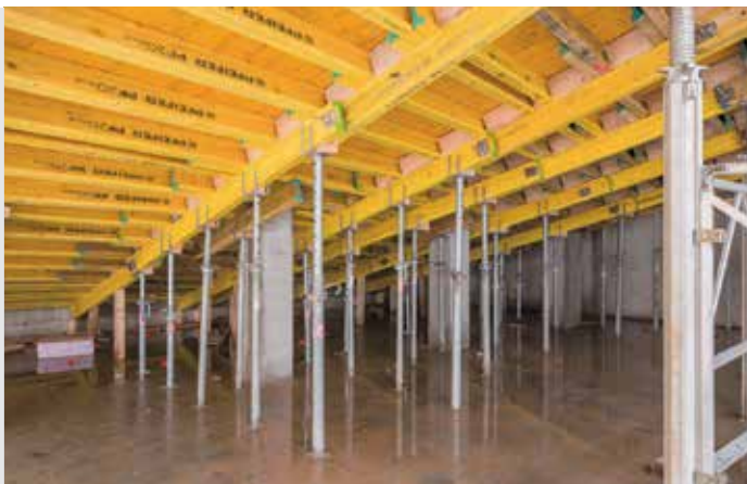
Die schrägen Böden der Hörsäle wurden mithilfe von Schaltafeln, H 20 Trägern und Euro-Deckenstützen betoniert. Hierbei nutzen die Baustellenmitarbeiter, dass sich die Deckenstützen in der gewünschten Höhe einstellen lassen.
